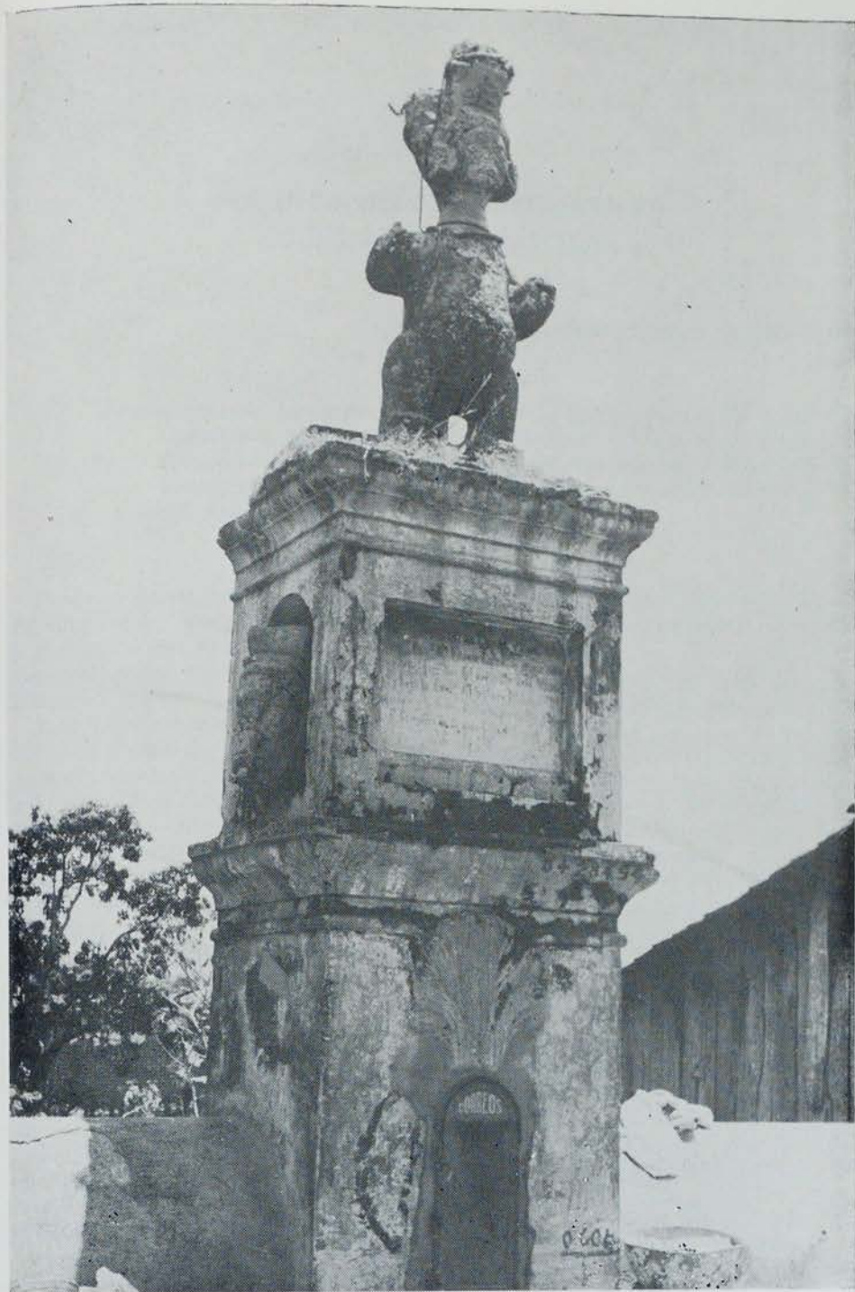
Lámina 4.— Vista del frente de la pilastra del «Puente Grande», Esquipulas.
